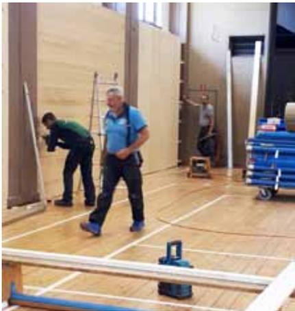
Und dann konnte es endlich so richtig mit „schaffa“ losgehen. Alle Wände bekamen eine Unterkonstruktion auf die bestehende Wand und darauf wurden die neuen Paneele draufgeschossen und am Ende verschraubt. Die eine Wand hat die Gruppe Garfield gesponsert, somit konnte diese Wand von einer Firma bearbeitet werden. Was natürlich schneller ging, als wenn wir die Abende damit verbracht hätten – Dankeschön! Die Giebelseite wurde in Eigenarbeit – in erster Linie von Jörg Betz – verkleidet.
